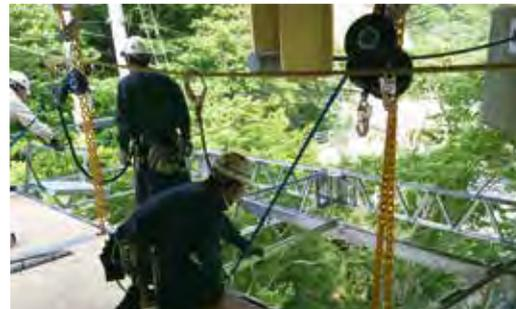
フィン、パネルを設置時に位置を合わせます。(ウッドデッキパネル、アルミデッキパネル)
